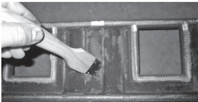
Bei abgenommenen Brennraumdeckel werden die Heizgaszüge sichtbar und zugänglich.
