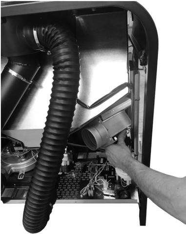
**Fig. 36 - Das Gehäuse + Ventilator am Ofen fixieren.**
