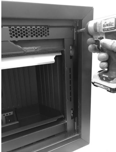
**Fig. 18 - Die Schrauben entfernen.**
