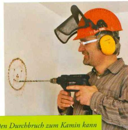
*Den Durchbruch zum Kamin kann man natürlich auch mit einem Kernbohrgerät machen. Mit Bohrmaschine und Meißel hat man eher weniger Staub in der Wohnung.*
