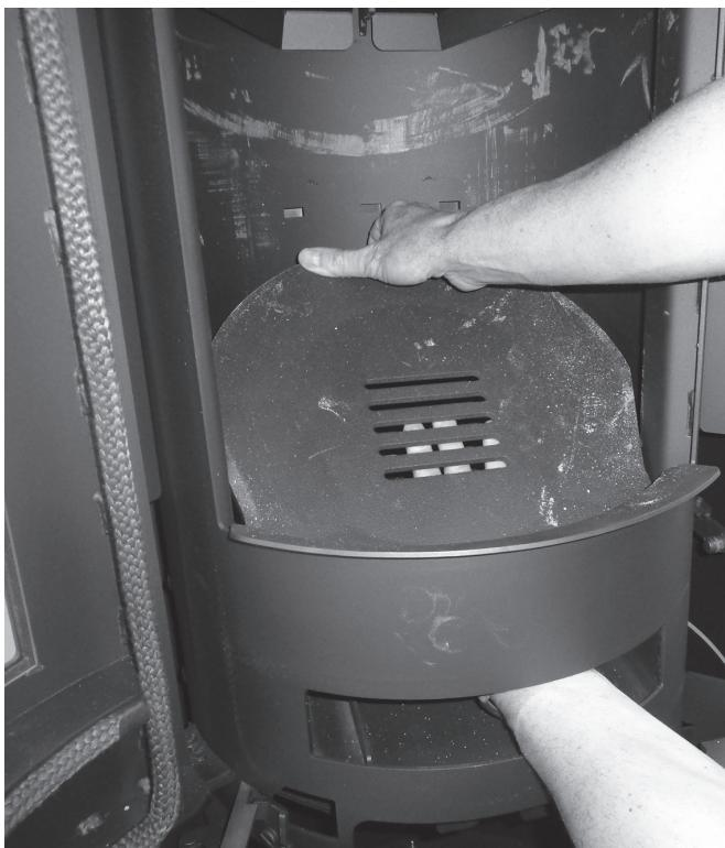
Un deuxième déflecteur métallique est situé au-dessus des déflecteurs en vermiculite.
