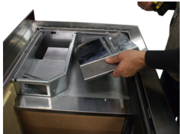
Fig. 23 - Das Umlenklech entfernen
