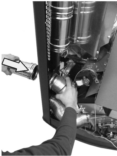
Fig. 66 - Positionierung der Rohre für Kanalisierung
