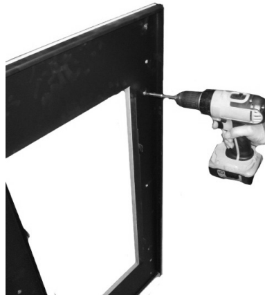
Fig. 28 - Die Steinelemente befestigen
