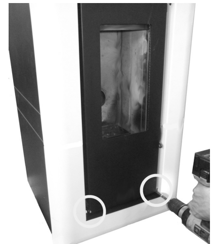
Fig. 26 - Befestigung Rahmen
