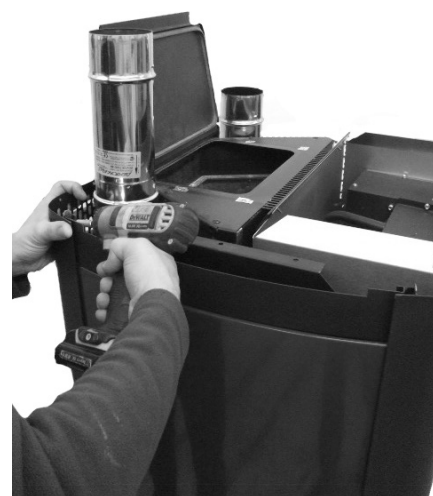
Fig. 47 - Wiederanbringen der oberen gebogenen Profile
