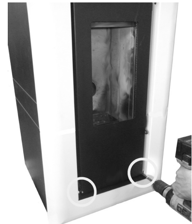
Fig. 32 - Befestigung Rahmen
