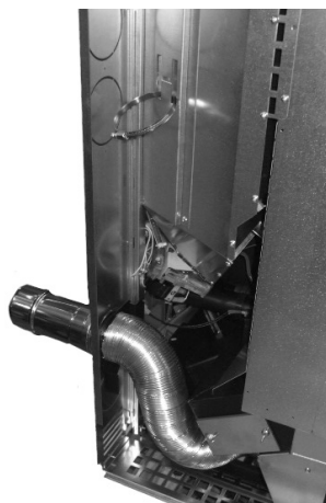
Fig. 58 - Positionierung der Rohre für hinteren Kanal
