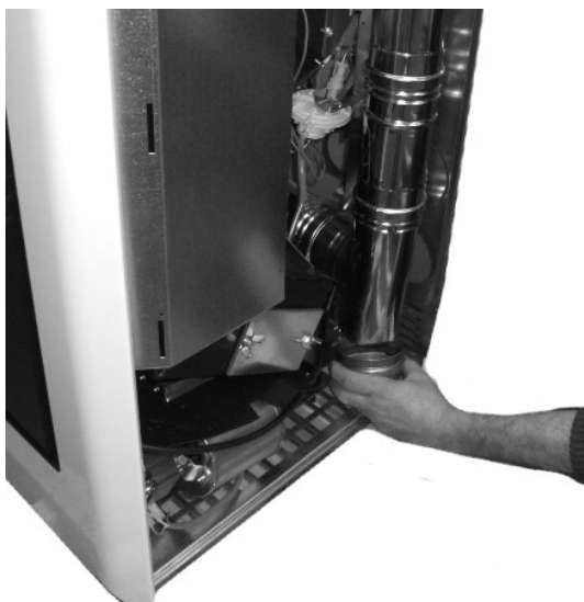
Fig. 102 - Reinigung des Rauchgaskanals
