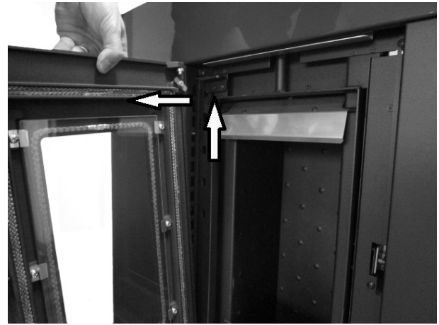
Fig. 53 - Ausbau der Tür
