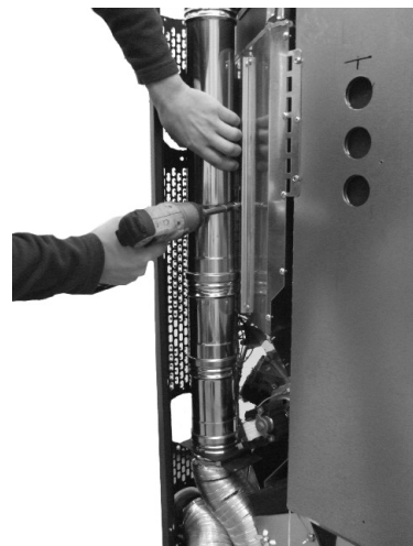
Fig. 64 - Befestigung der Rohre
