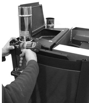
Fig. 91 - Entfernen der oberen gebogenen Profile
