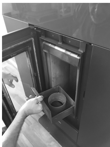
Fig. 24 - Reinigung Brennschale
