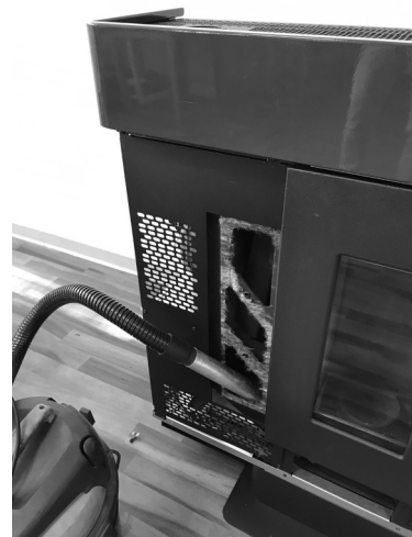
Fig. 33 - Reinigung Rauchgaskammer
