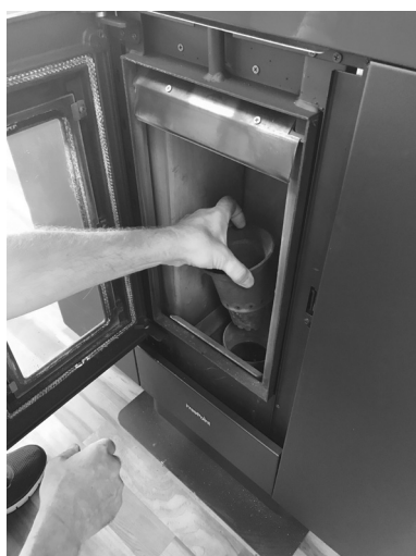
Fig. 23 - Brennschale entnehmen
