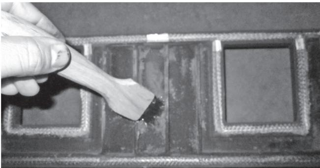
Bei abgenommenem Brennraumdeckel werden die Heizgaszüge sichtbar und zugänglich.
