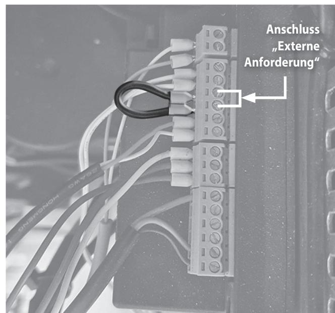
Es wird die **Steuerelektronik** sichtbar. Der Anschluss erfolgt an die entsprechende Klemmenleiste.
