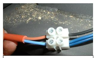
11. Elektrische Leitung am Kabelbaum (Nr. 5) anschließen.
